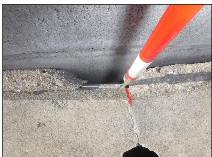
⑯ 境界標識：金属プレート
