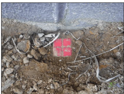
④ 境界標識：プラスチック杭
