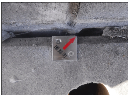
⑬ 境界標識：金属プレート
