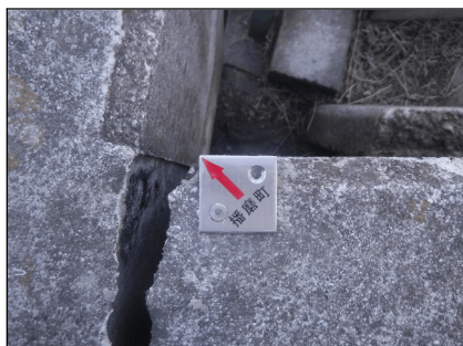
⑳ 境界標識：金属プレート
