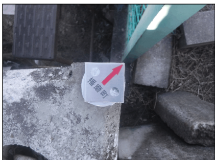
⑲ 境界標識：金属プレート
