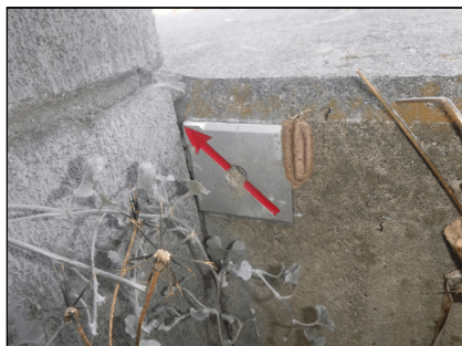
⑪ 境界標識：金属プレート
