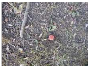
⑩ 境界標識:プラスチック杭
