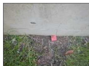
⑯ 境界標識: プラスチック杭
