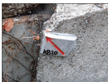
②⑧ 境界標識：金属プレート
