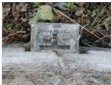
③⑤ 境界標識：コンクリート杭
