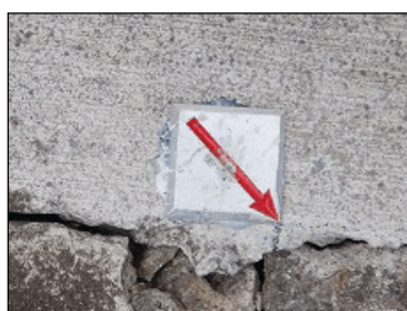
⑭ 境界標識：金属プレート
