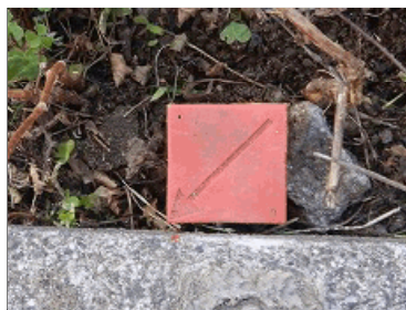
③④ 境界標識：プラスチック杭
