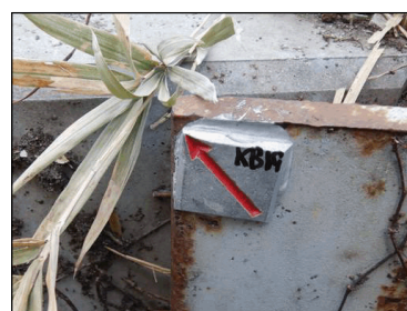
②⑦ 境界標識：金属プレート
