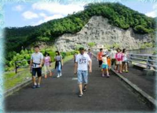
【ダムの堤体上を歩いて観察】
