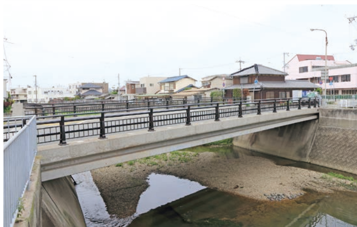
向橋（橋梁長寿命化改修済）
