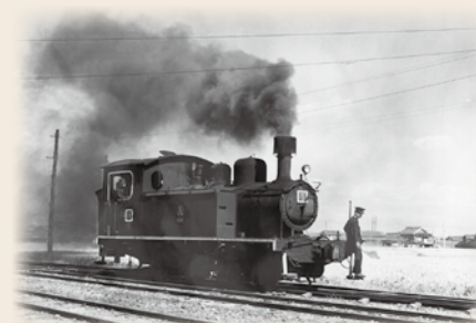
5号機の機まわり風景 別府港
