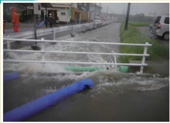
▲ポンプで低地の雨水を水路に排水する様子 (8月10日台風11号 町内で撮影)
