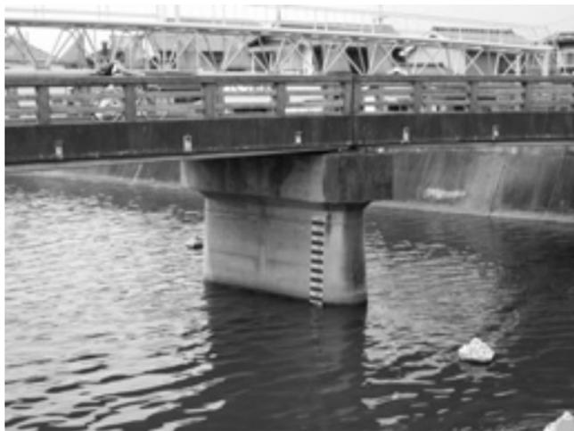
▲水位を確認する量水標を設置した橋桁
