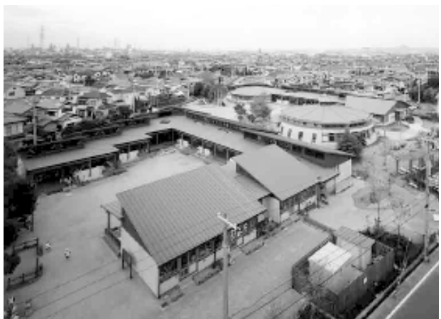
高所から見た蓮池幼稚園周辺
