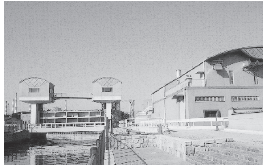
排水ポンプ場と水門
