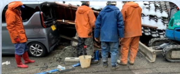
家屋倒壊、メーターボックスが下敷 修繕工事が終わるまで近所も断水
