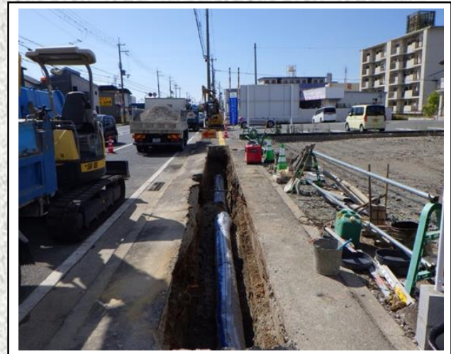
令和5年10月工事の様子 (東本荘2丁目付近)
