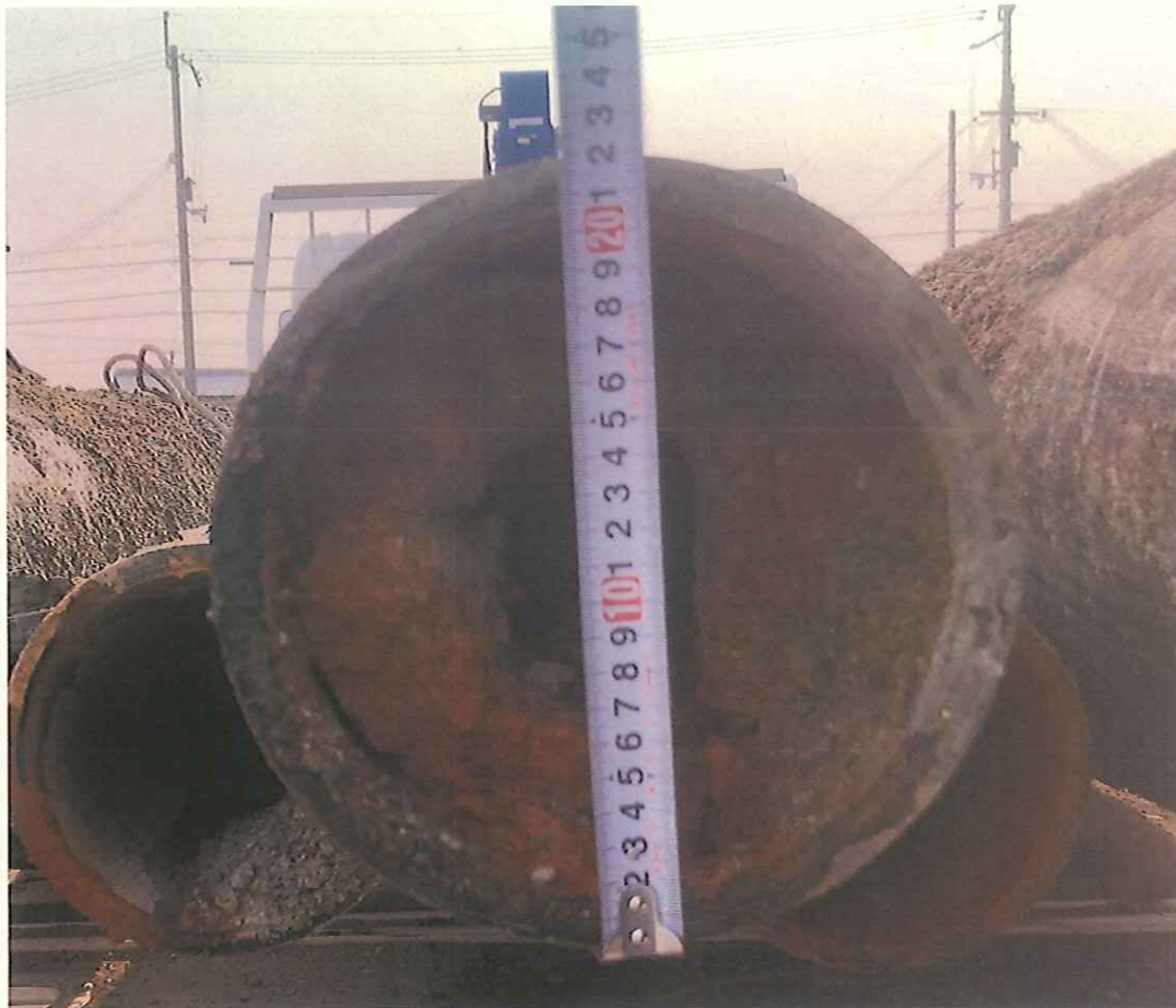
① 1978年製 基幹管路 1工区 導水管撤去 φ200 堆積土砂
