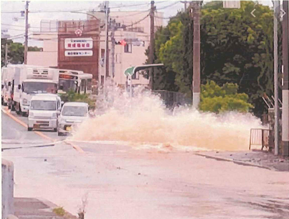
⑦参考 2018.6 大阪北部 地震漏水
