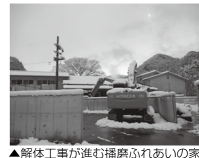
▲解体工事が進む播磨ふれあいの家
