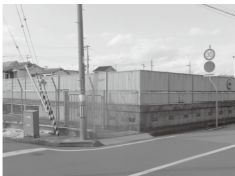
▲災害時の生活用水専用蛇口が設置される播小プール
