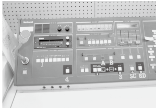
▲役場屋上のアンテナ、1階のシステム操作卓などの防災行政無線設備がデジタル化される予定
