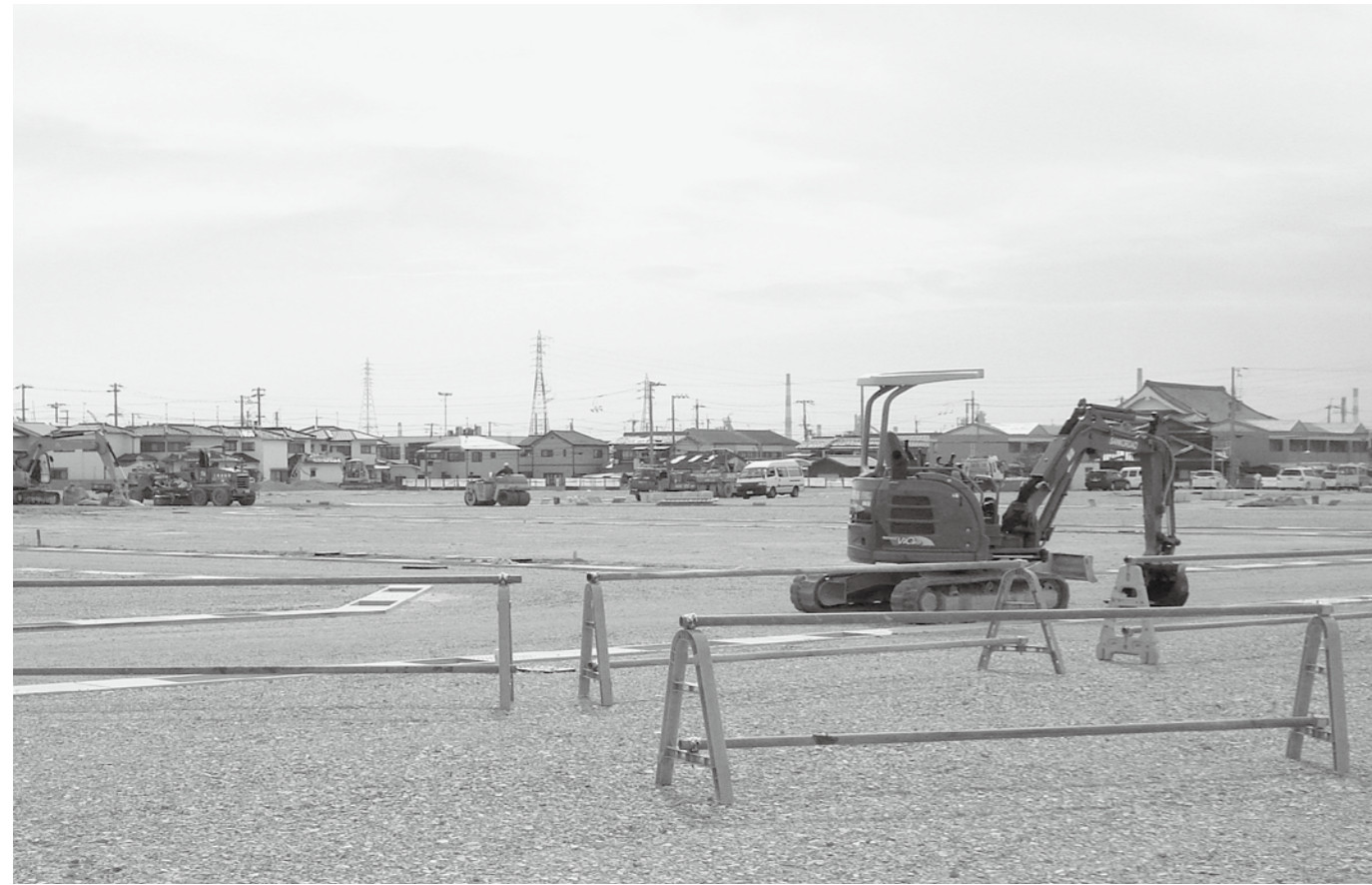
▲良好な住環境にするため、地区計画によりまちづくりのルールを決めた「古宮第1地区」(旧ダイボウ社宅跡地)
