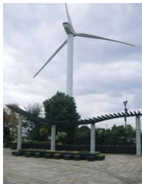
水の森の風力発電機
