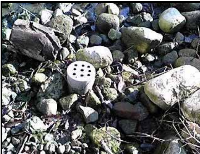
【第2号池取水口の様子】
