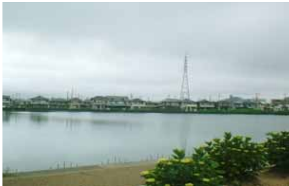
北池ポンプ庫周辺
