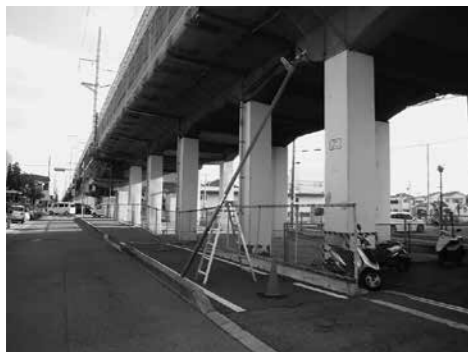
街灯の根元が腐食して、倒壊しました
