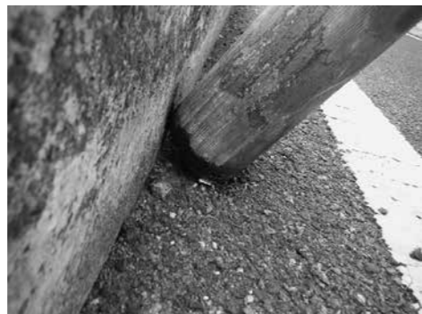
腐食部分の様子
