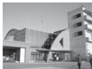
▲加古川市防災センター
