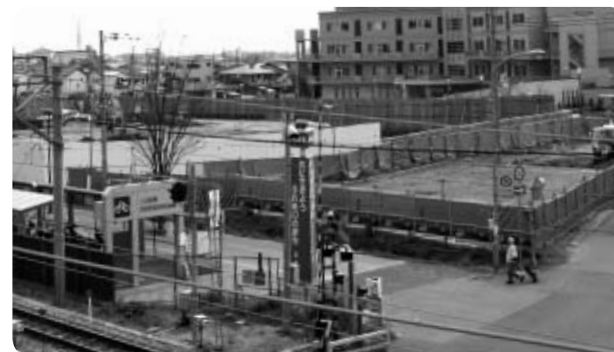
▲土山駅南町有地（現在、土壌改良工事中）
