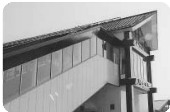
▲JR土山駅南側より
