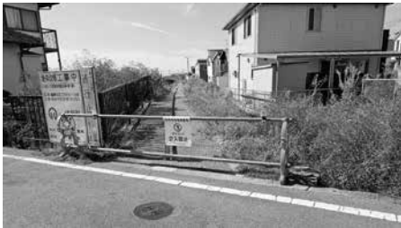
大池西側の遊歩道
