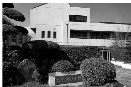
▲安全な外壁に
